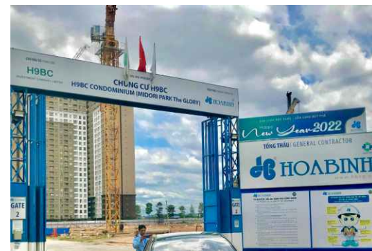
Công trường thi công chung cư H9PC - Bình dương Construction site of H9PC apartment building - Binh Duong
