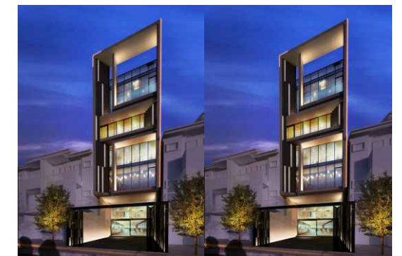
Chiếu sáng Facade tòa nhà văn phòng Office building facade lighting
